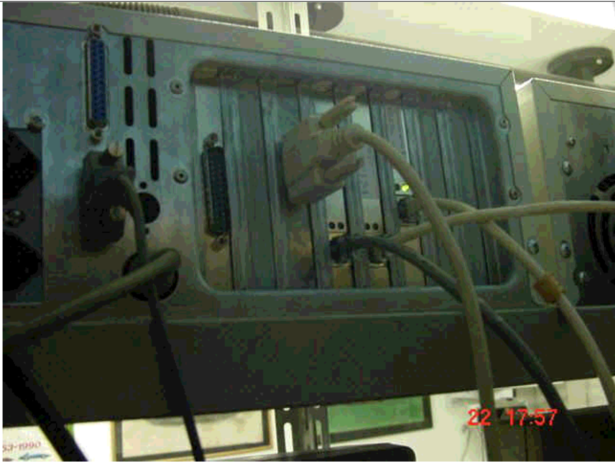
Figura 3.23 - Em operação com o script de Firewall carregado
